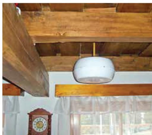
**PRÍSTROJ SA ZVÄČŠA MONTUJE na strop v suteréne alebo v prízemí.**
